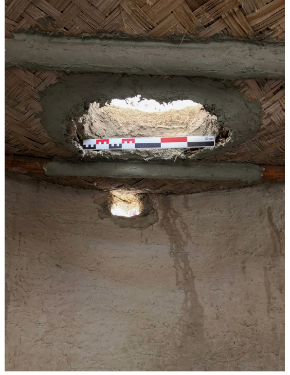
Şekil 12. Çamur ile sıvanan ahşap kirişler ve baca açıklığı (Boncuklu Höyük Araştırma Projesi Arşivi).
